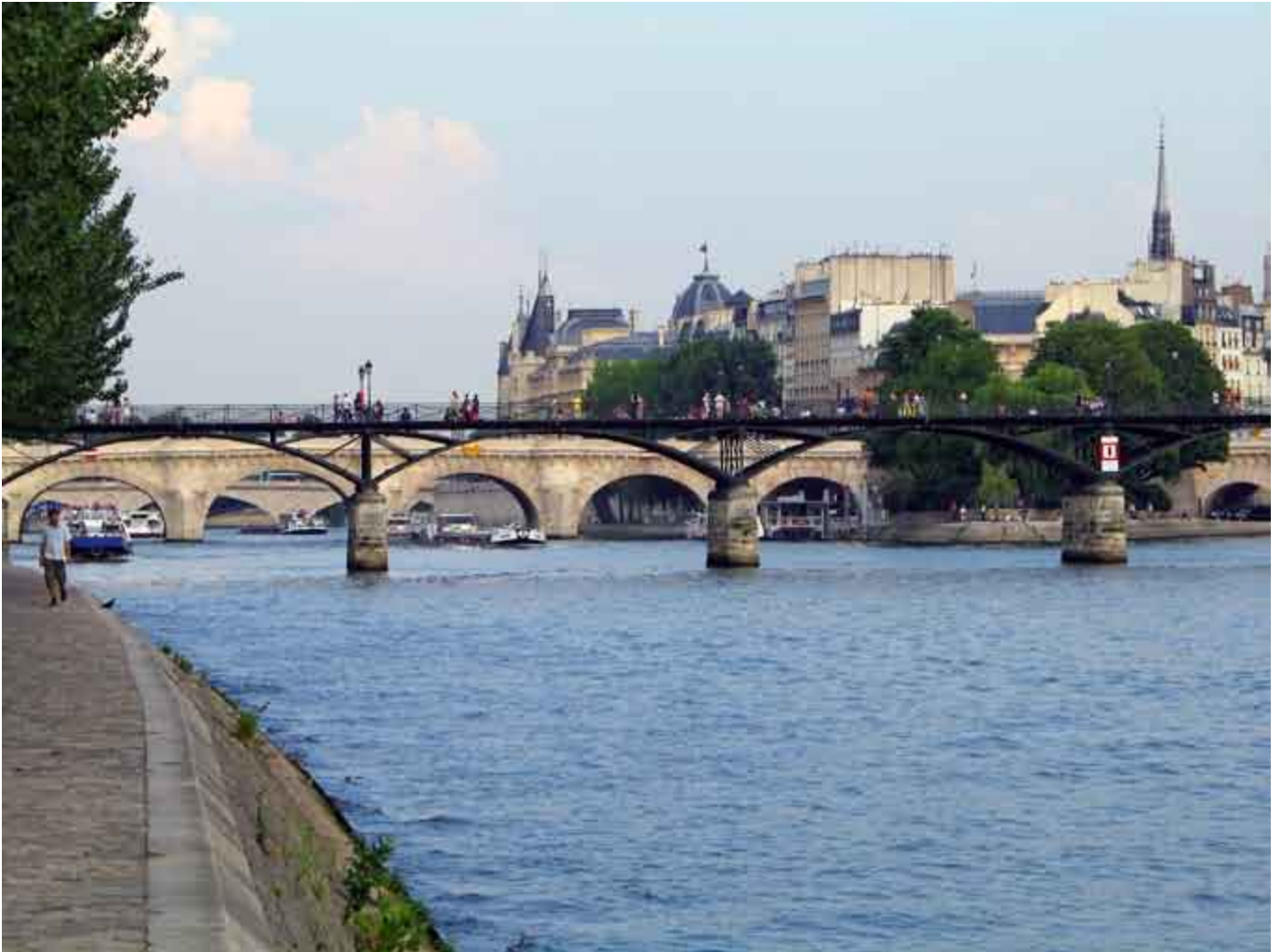
Pont des Arts, vista geral. (foto Milton Braga)
