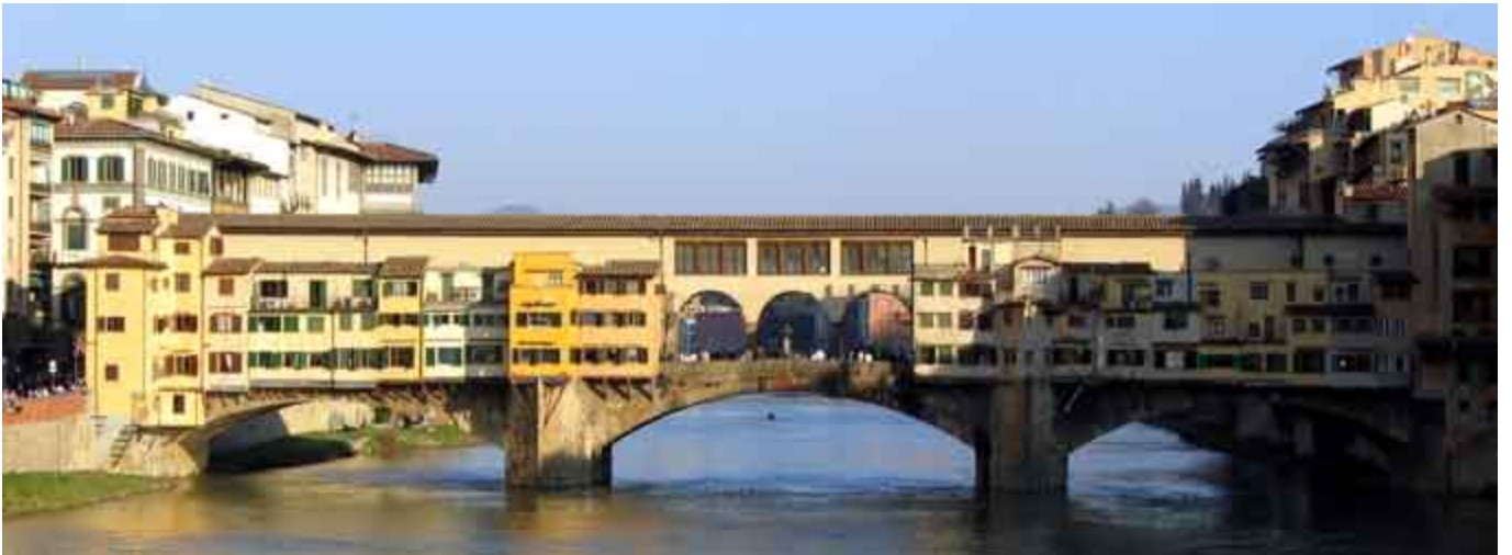
Florença, Ponte Vecchio. (fonte arquivo do autor)
