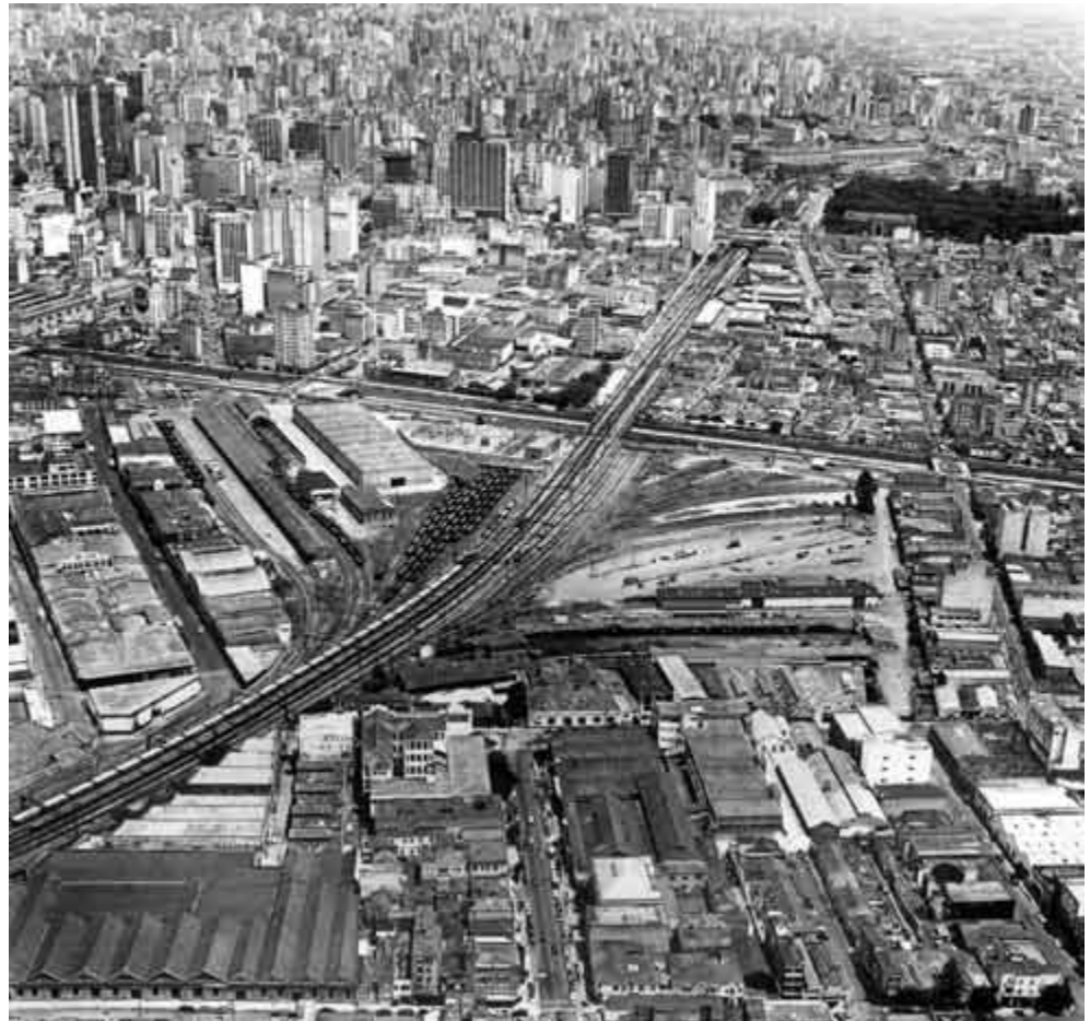
Ramal e pátio ferroviário da CPTM no Pari. (foto Nelson Kon)
