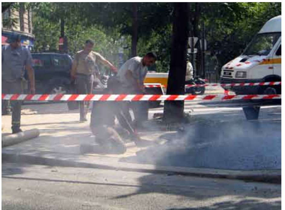
Paris, calçamento com asfalto. (foto Milton Braga)
