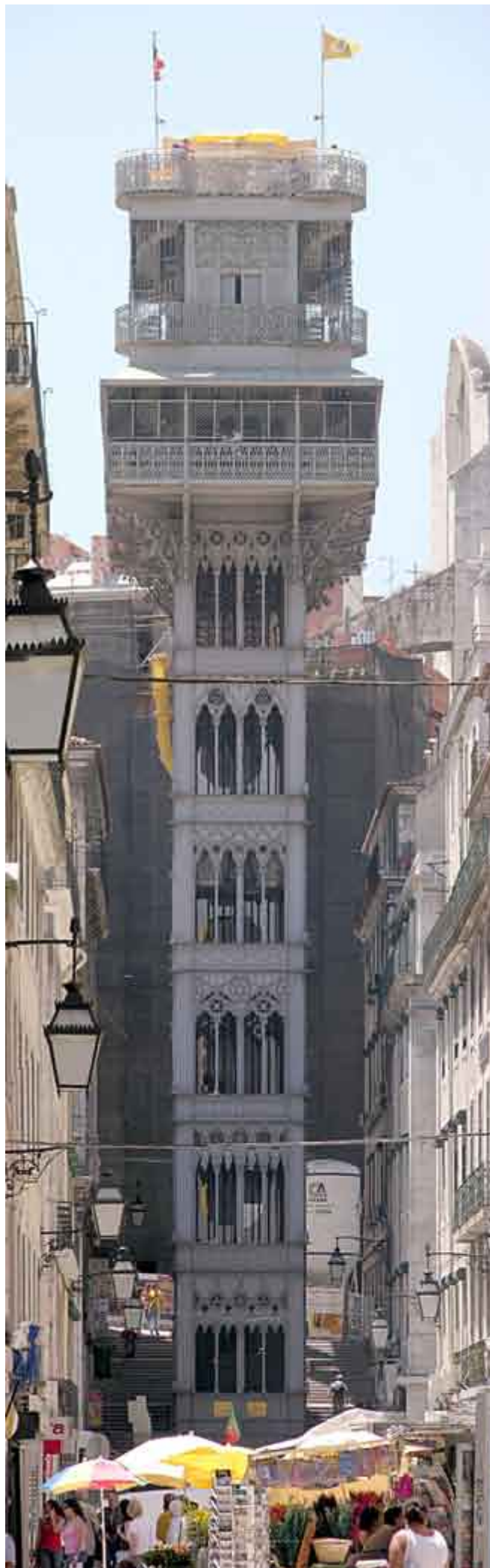
Lisboa, Elevador Santa Justa. (fonte arquivo do autor)
