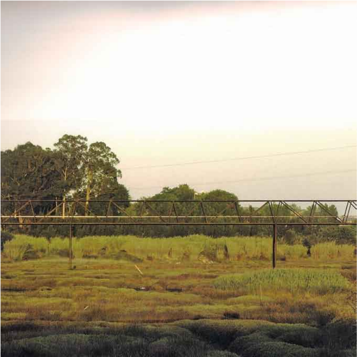
Passarela de pedestres na zona universitária de Santiago, em Aveiro, Portugal: a passarela projetada em 1997 por João Luís Carrilho da Graça une a parte antiga do campus com uma nova extensão, separada da primeira pelo Esteiro de S. Pedro. Fonte: OLIVEIRA, Luís Valente (comissário geral). Des-continuidade: arquitectura contemporânea, norte de Portugal. Porto: Civilização Editora, 2005, (catálogo).
